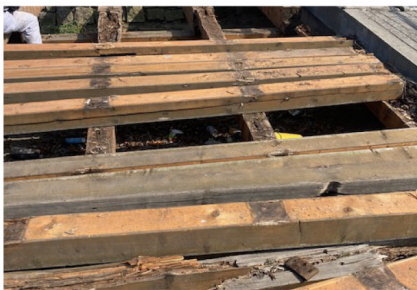
Oprava drevenej lávky pri hlavenej ceste pred a po realizácii.
