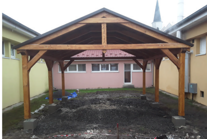
Prvá etapa projektu - stavba dreveného altánku
